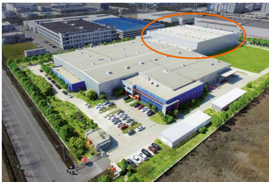
Heimbach Suzhou: Die neue Produktionshalle oben rechts im Bild.
