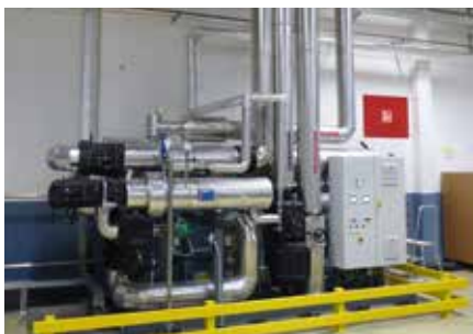
Wärmetauscher Öl/Heißwasser
