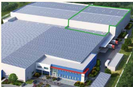
3. Bauabschnitt Heimbach Suzhou, China
